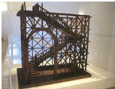
Sogenannter „Pombaliner Käfig“: An Erdbeben und Brandgefahr besser angepasste Bauweise nach dem Erdbeben von Lissabon 1755 (modernes Modell)
