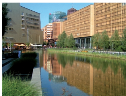
Dachbegrünung, Regenwasser-nutzung und Urbanes Gewässer am Potsdamer Platz Berlin (Priorität 2, 6 und 3 in Kombination)
