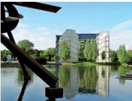
Potsdamer Platz – urbanes Gewässer Bei Starkregenereignissen kann die Wasserfläche bis zu 30 cm über dem Mindestwasserspiegel angestaut werden.
