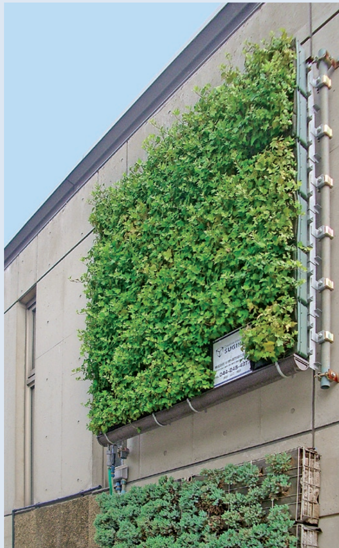
Testinstallation zur Fassadenbegrünung
