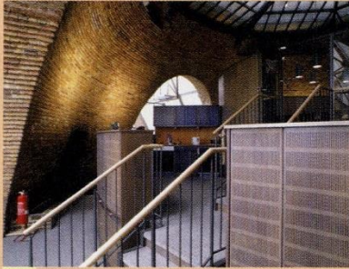
Das ausgebaute Dachgeschoß
