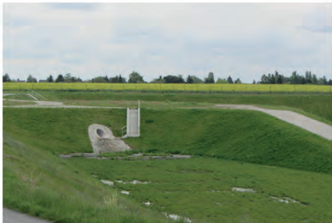
Regenrückhaltebecken. Quelle: BWB
