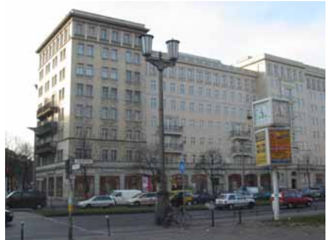
Beispiel Wohngebäude Frankfurter Allee 26
