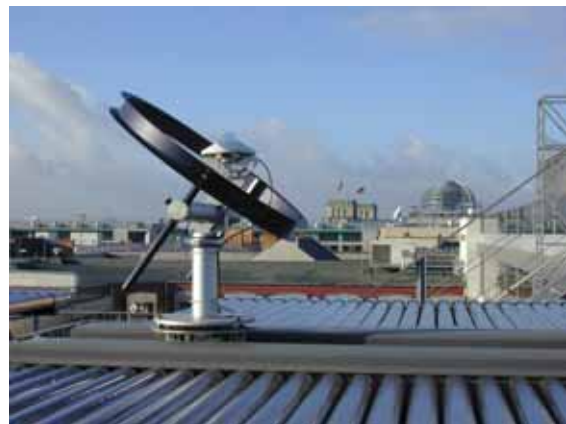
Kollektorfeld einer thermischen Solaranlage
