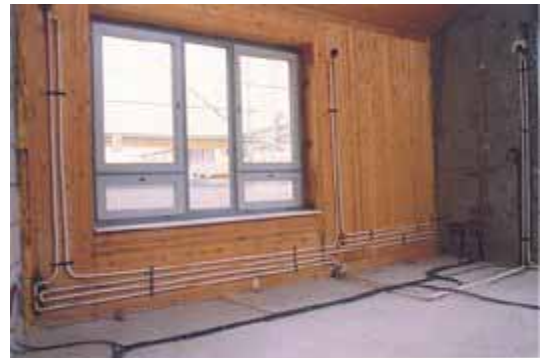
Außenwand-Flächenheizung während der Bauphase
