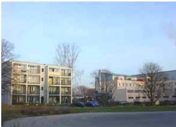
Solaranlage Buchholz West
