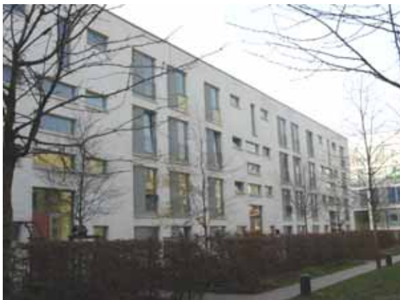
Rudow Süd, Innenhof
