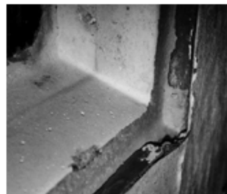
Ausbruch durch Demontage der Fenster
