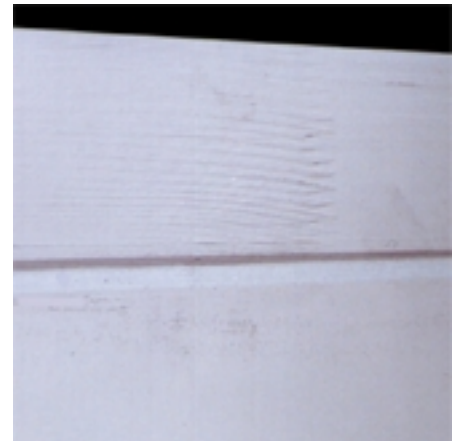
Sichtbare Keilzinkung
