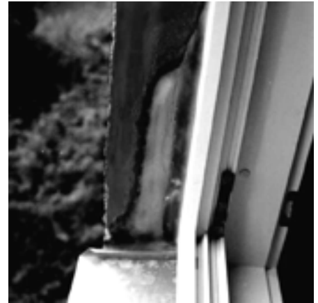
Ausfüllen von Ausbrüche mit Dichtstoff
