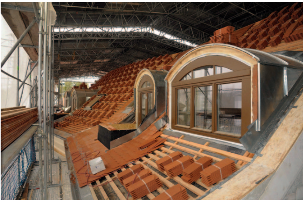
WBM-Dachausbau in der Friedrichstraße 129, Mitte
